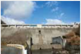
① 八塔寺川ダム
