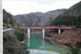
③ 八塔寺大橋
