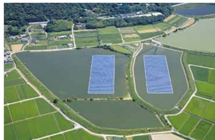
太陽光発電所
